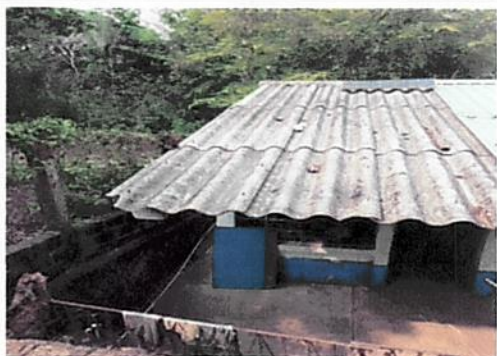
Foto 3: Cambio de techo y piso de cocina.
