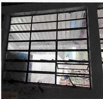
Foto 5: Instalación de ventanas tipo PVC.
